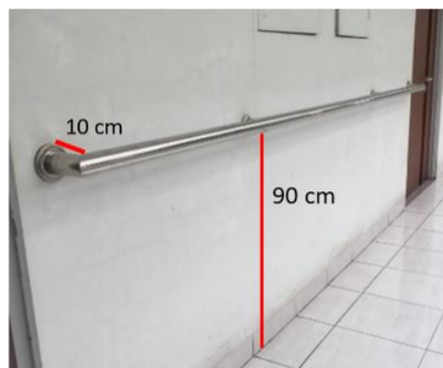
Gambar 9. Handrail di Seluruh Koridor Bangunan
